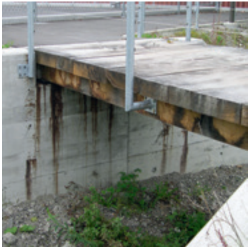
Oben: Vorsicht bei benachbarten Bauteilen und deren Eigenschaften. Die Eichenbalken (Brücke) respektive deren natürliche Inhaltsstoffe verursachten diesen Schaden.
