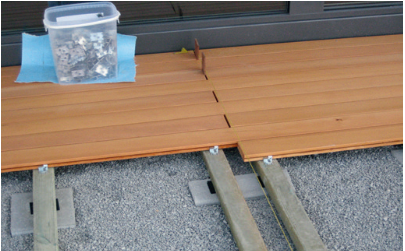
Konstruktiver Holzschutz: Die einzelnen Holzbretter schliessen nicht direkt aneinander an, Feuchtenester können so gar nicht erst entstehen.
